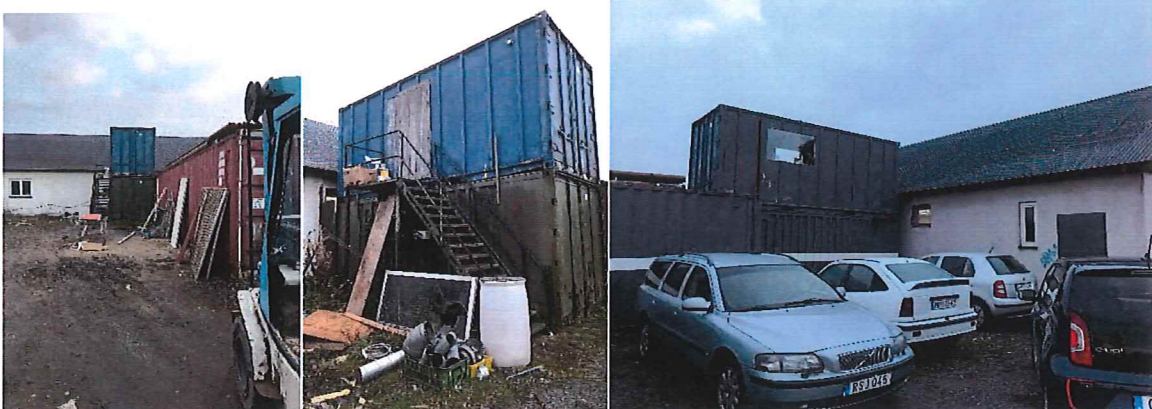
Bilderna visar byggnader B3B, B3C och B21. Byggnad B3C höll på att byggas om under besöket och skulle bli en DJ-booth/festlokal. Ombyggnationen hade pågått i ca 2 veckor och personen som hyrde byggnaden bodde på annan plats inom fastigheten. Byggnad B3C hade tidigare använts som förråd och ett fönster hade tillkommit.
