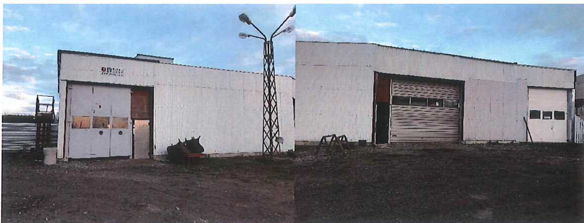
Den vänstra bilden visar tillbyggnad T3, samt del av plank P9 och del av byggnad B8. Den högra bilden visar byggnad B8, samt del av tillbyggnad T4.
