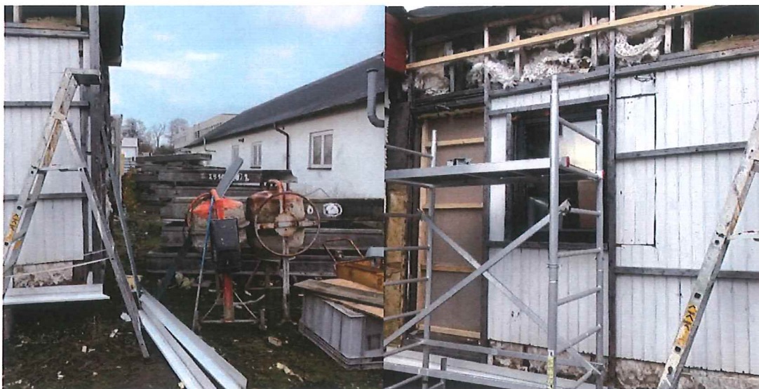
Den vänstra bilden visar del av upplag U, samt del av byggnad B4A och del av byggnad B21. Den högra bilden visar byggnad B4A samt del av byggnad B11 till vänster på den högra bilden som byggs ihop med byggnad B4A.
