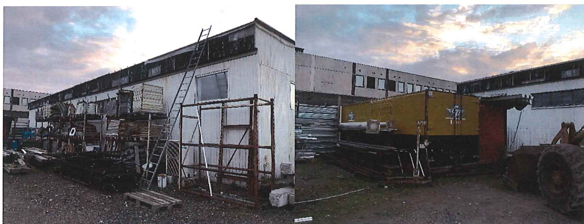
På den vänstra bilden syns upplag placerat öster om byggnad B8. På den högra bilden syns byggnad B18 i form av en röd container, byggnad B19 i form av en orange-svart container, del av byggnad B9 och del av plank P10.
